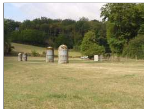
Galerie drainante des sources de Fleury (Lavausseau)
