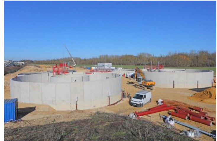
© Nicolas Mahut, Construction de la STEP à Chasseneuil
