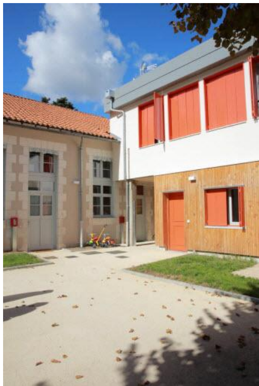
Ecole Saint-Louis réhabilitée en logement social, Poitiers
