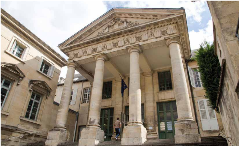
Entrada monumental 1822 - Kolossaler Eingang 1822
