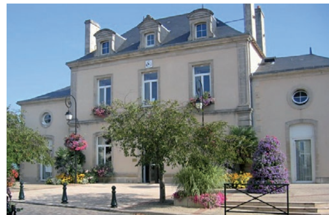
La mairie de Chasseneuil
