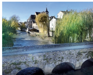
Le pont dit le Vieux Pont ou Pont Raveau
