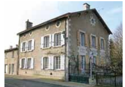
La maison dites «des glycines».
