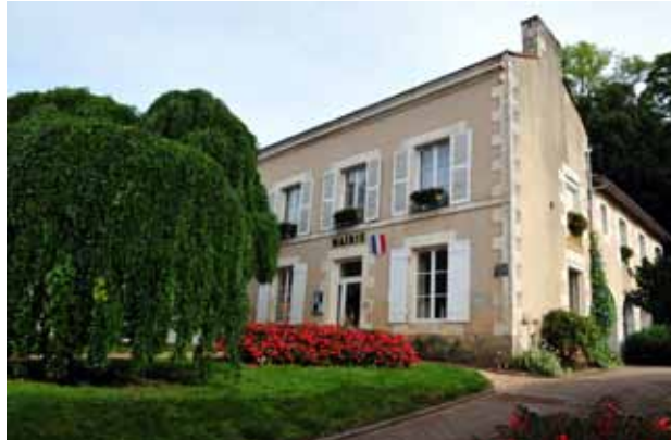
L'actuelle mairie occupe l'ancien presbytère depuis 1989 après travaux et agrandissement par l'architecte Christian Mongiatti de Poitiers.
