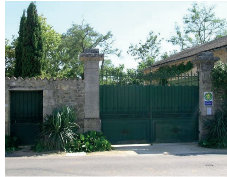
Portail d'entrée à piliers maçonnés et à porte piétonne
