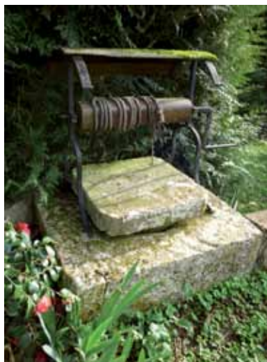
Puits - Rue de la Creuzette
