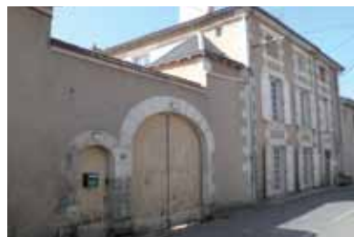
Logis d'habitation et passage couvert - Rue du Centre
