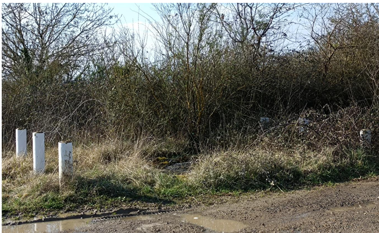
Photo 6 : Puit de secours en bordure de chemin (diamètre 1 m avec balisage)
