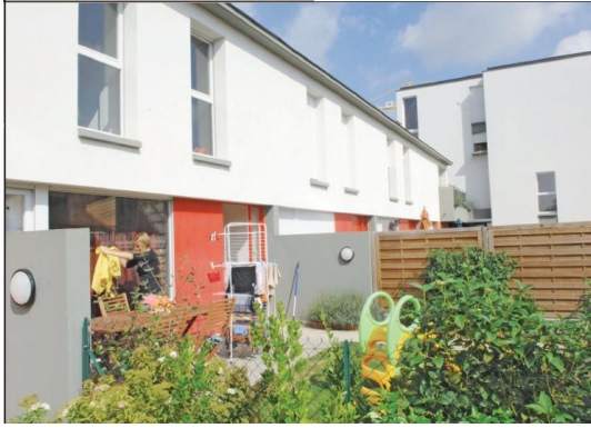
Photo logements à Servon sur Vilaine, JAM architecture
