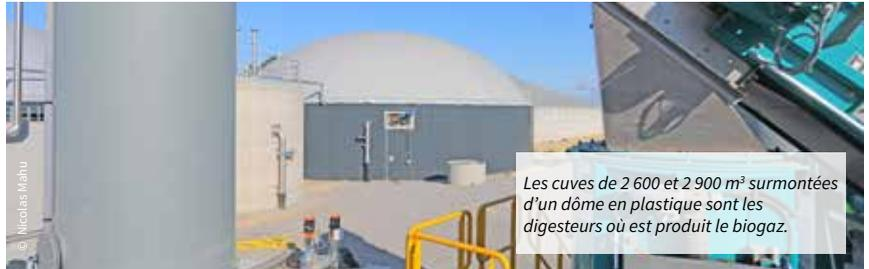
Les cuves de 2 600 et 2 900 m<sup>3</sup> surmontées d'un dôme en plastique sont les digesteurs où est produit le biogaz.
