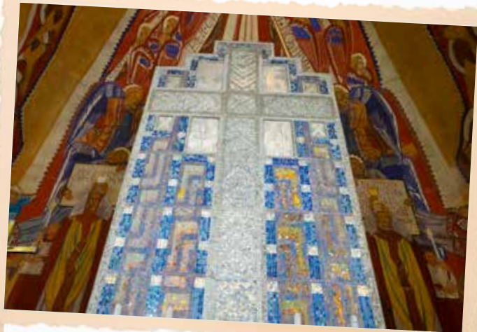
▲ Du projet à la réalité, la structure totalise 41 panneaux maintenus au mur par des tirants de fer.
