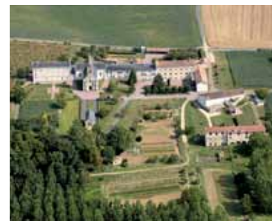
Le couvent de Salvert - Vue aérienne
